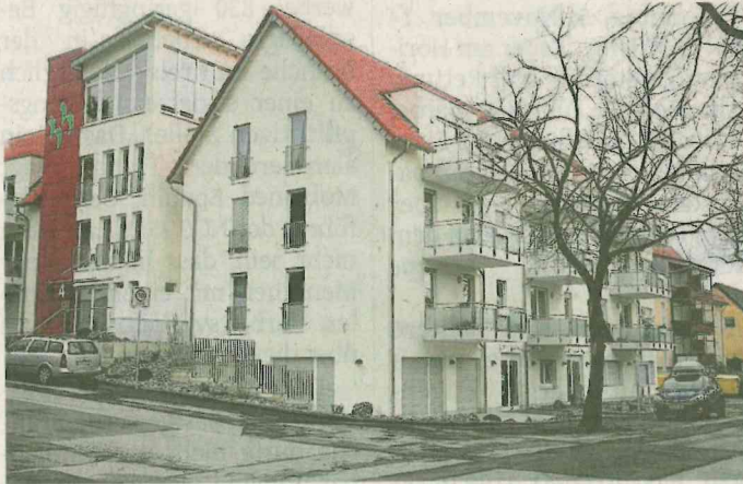
An der Wielstraße entstand eine Mehrgenerationen-Haus. Das könnte ein Beispiel für weitere Projekte sein.
