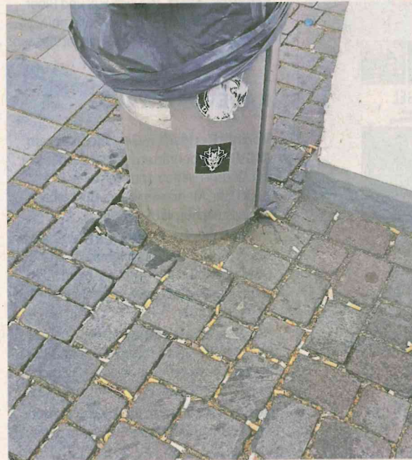
Kein schöner Anblick: Zigaretten, die einfach auf den Boden neben einem Aschenbecher geworfen werden, „zieren“ den Gehweg an der Telegrafens- straße.
