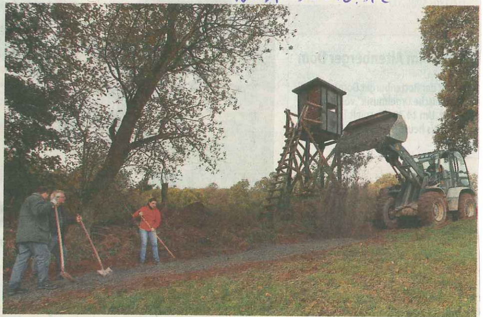
Mit Radlader und Schaufel ausgerüstet haben Mitglieder des Verschönerungsvereins Dhünn und der WNK UWG den neuen Weg am Samstag angelegt.
